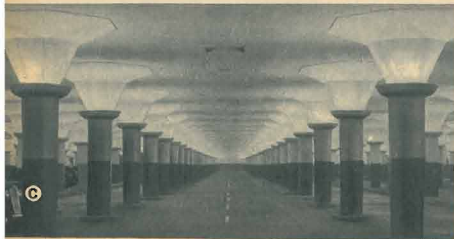
C Questa grande autorimessa sotterranea è stata costruita sotto una delle principali arterie che attraversano il centro di Buenos Aires ed ha l'entrata e l'uscita nella stessa direzione delle correnti del traffico.
